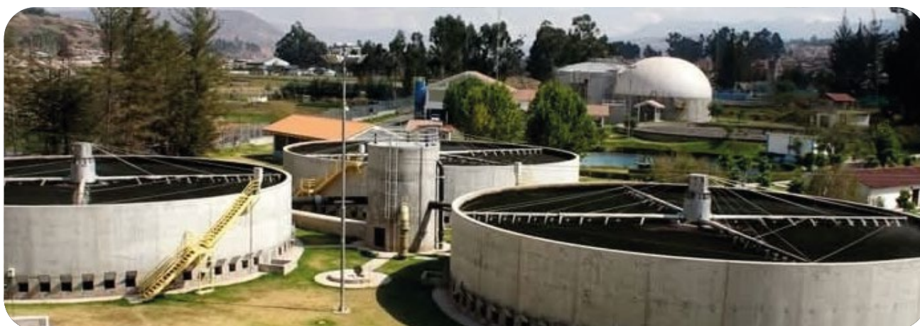
Pozos de sedimentación en la Planta de Tratamiento de Aguas Residuales (PTAR) - San Jerónimo.
